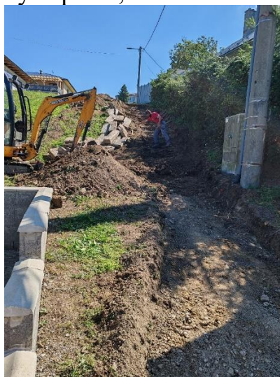
Foto: Rekonštrukcia schodov
